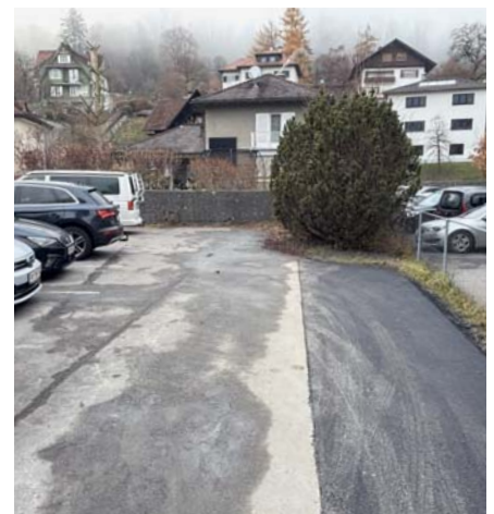
Parkplatz bei der Pauluskirche saniert
