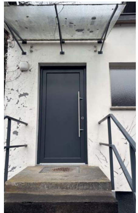
Neue Außentüre Sakristei
